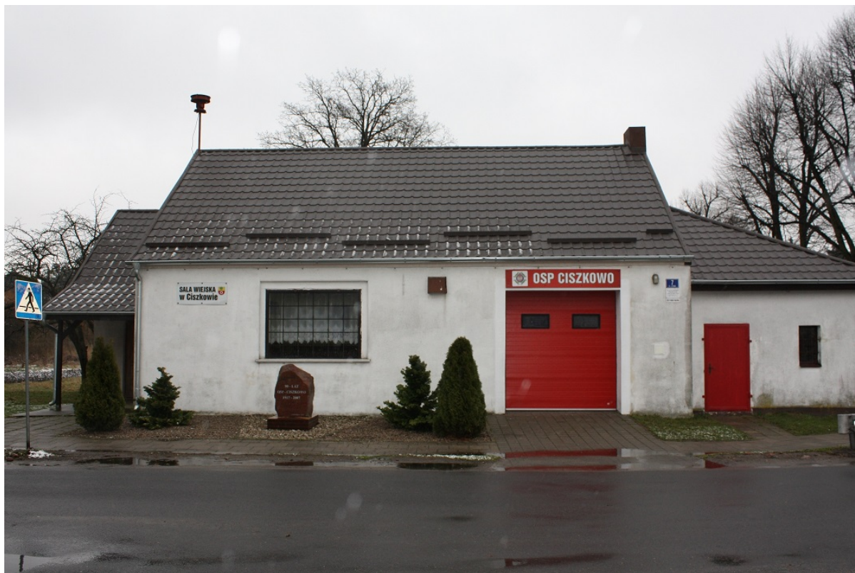
Ciszkowo - Sala Wiejska
